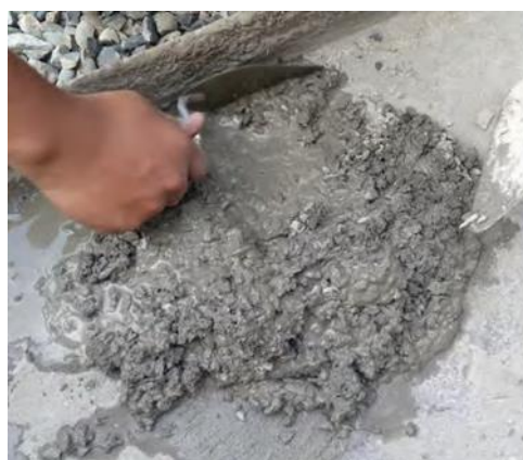
Gambar 18. Pengadukan campuran agregat beton
